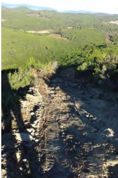
Neteja de camins. Exemple del tipus de treballs que fan les ADF habitualment. © @federacioADF_PG
